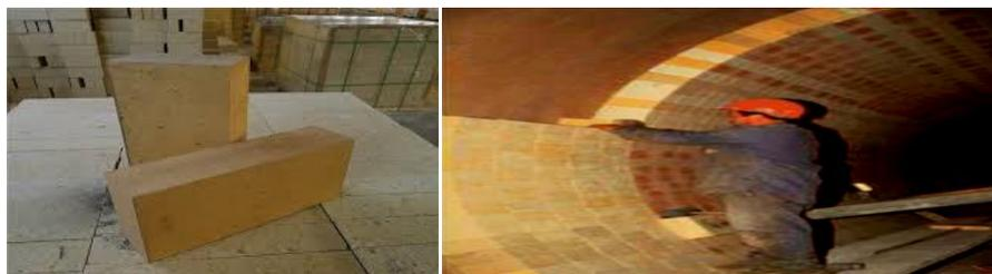
Figure I.10: Briquetage dans un four rotatif de cimenterie.
