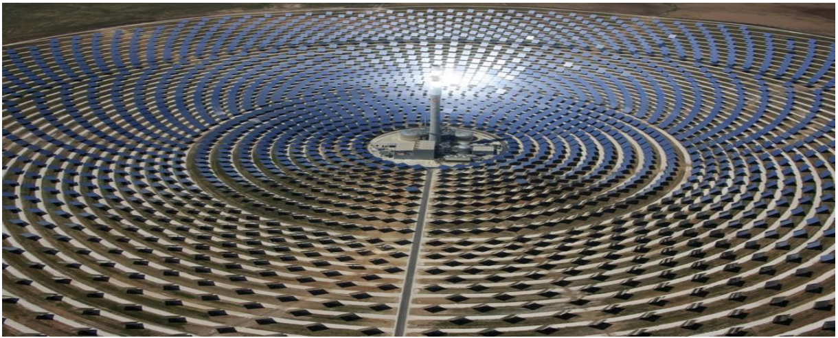
Figure : I-16 : Les centrales à tour
