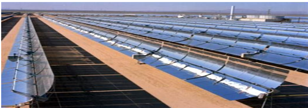
Figure : I-15 : Les collecteurs cylindro-paraboliques
