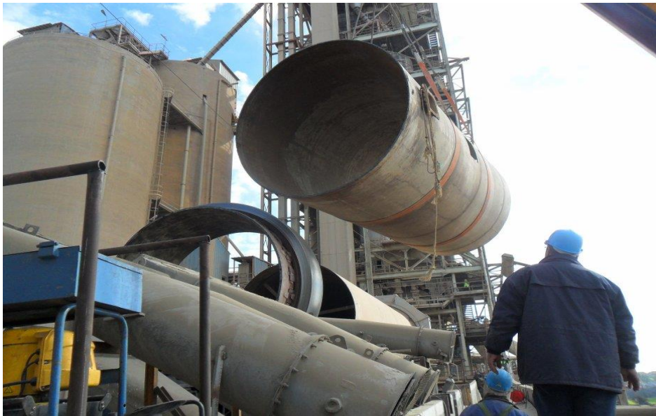
Figure (I.14) : montage d'une virole d'un four rotatif
