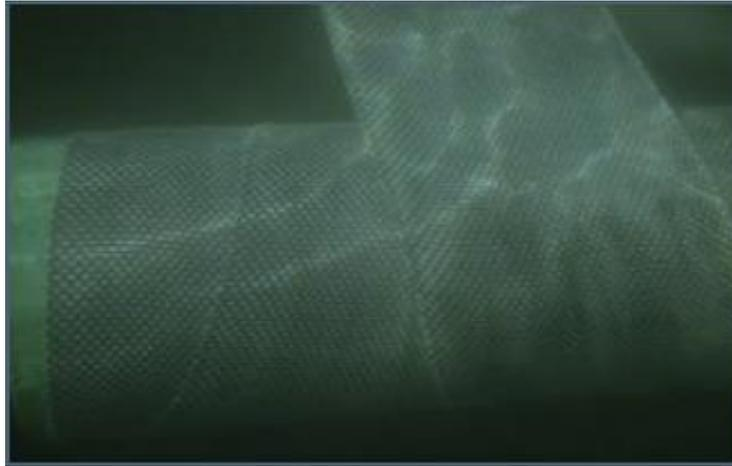
**Figure II.10.** Emballage de composite flexible pour la réparation sous – marine [12], [13]
