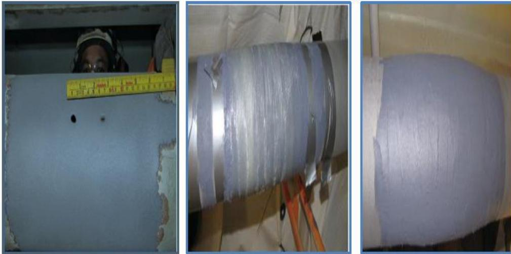
Figure II.9. Réparation par composite d'un pipeline en acier
