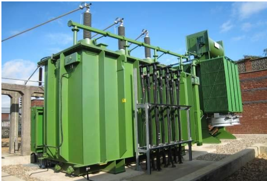
Figure II. 17 Transformateur à huile végétale FR3 développé par Cargill.
