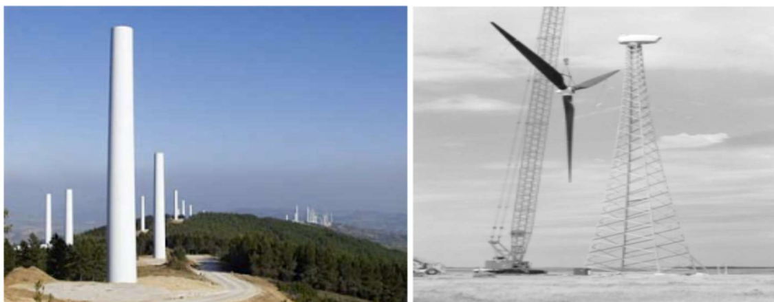
a) Tour tubulaire
