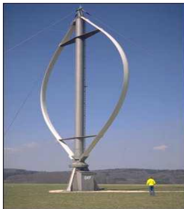
Figure I-8 Aérogénérateur à axe vertical (structure de Darrieus)
