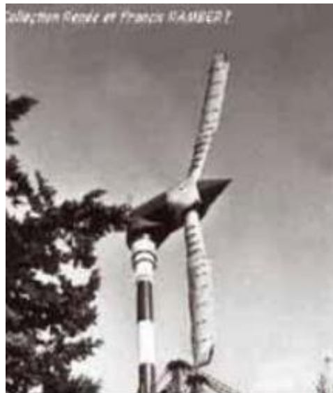
Figure I-6: Eolienne de 100 kW de Grand Vent
