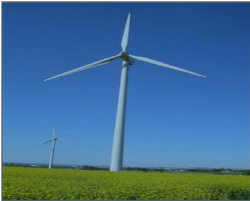
Figure I-10 Aérogénérateur à axe horizontal
