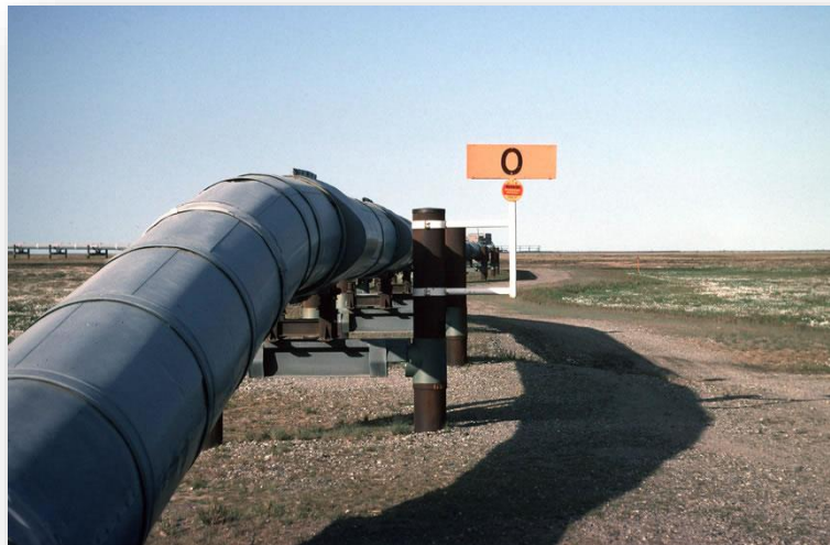
Figure 1.4 L'oléoduc trans-Alaska reliant Prudhoe Bay à Valdez sur près de 1 300 km [5].
