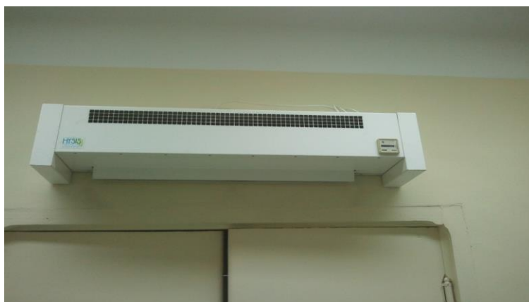
Figure IV.12 tubes-néon à rayonnement ultraviolet
