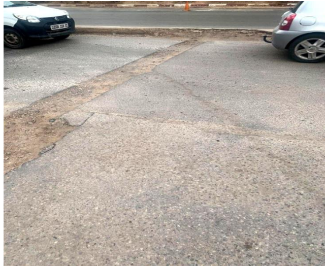
Fig II.11 : Affaissements localisés
