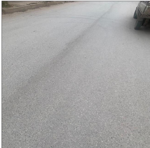
FigII.10 : usure superficielle prononcée, traces de pneus.
