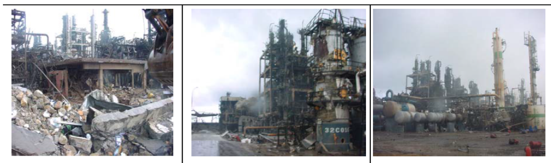
Figure 1.4: complexe GL1K (unité 20, 30,40) après l'accident.
