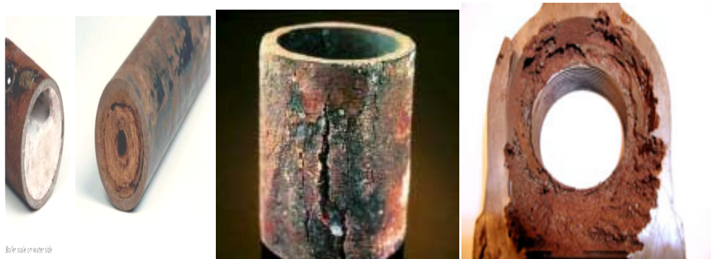
Figure I.17 : corrosion et entartage des tubes des chaudières.
