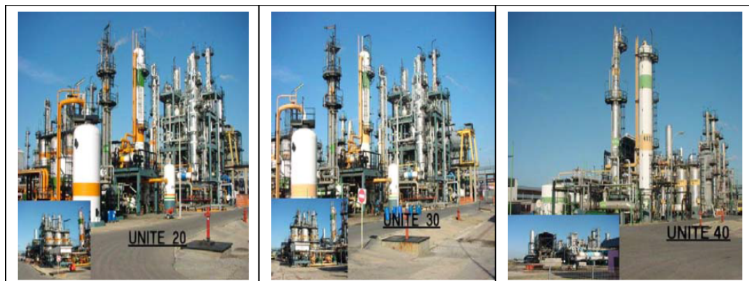
Figure 1.2 : complexe GL1K (unité 20, 30,40) avant l'accident.
