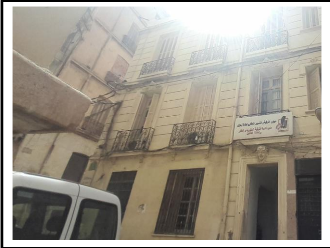
الصورة رقم 20 : تجهيز إداري بحي الدرب
