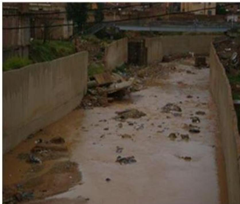
Figure 18 : Oued Deffa avec les voiles de protection en partie détruits
