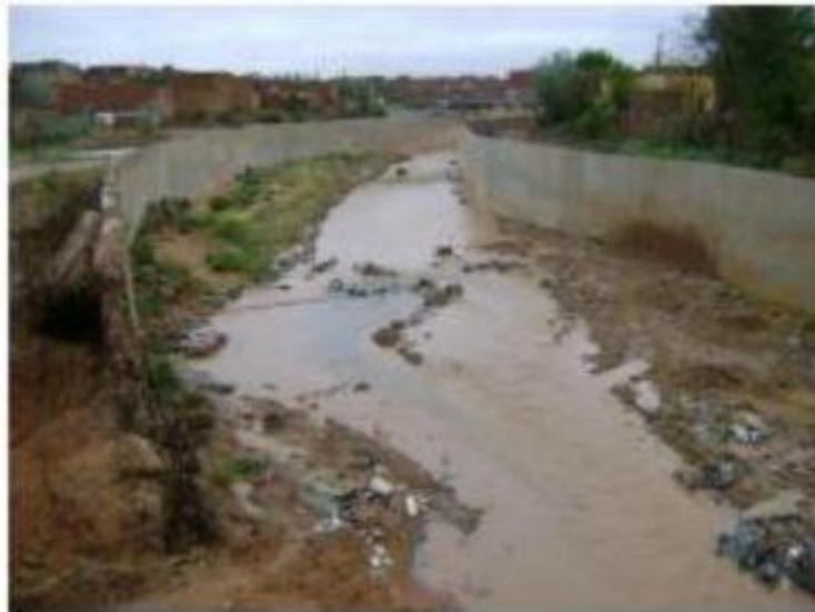
**Figure 17 : Oued Deffa avec les voiles de protection en partie détruits**
