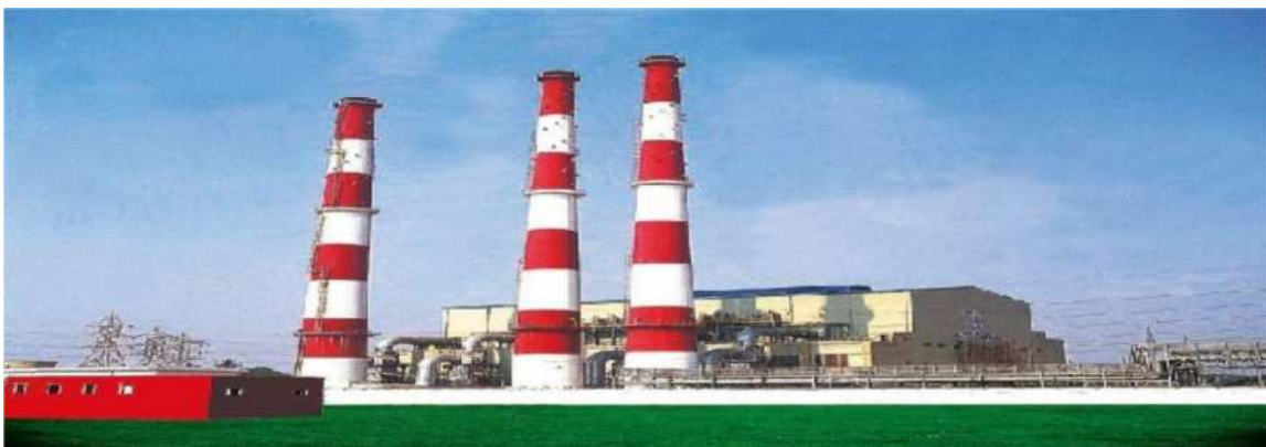
Figure III.8 : Une centrale Diesel.[08]
