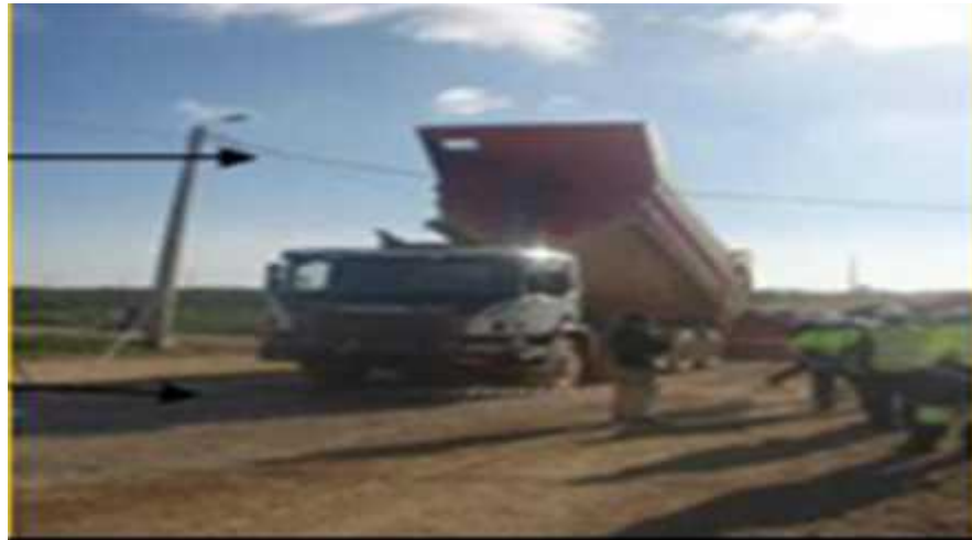
Figure II.7 : Contact de la benne du camion avec une ligne électrique.
