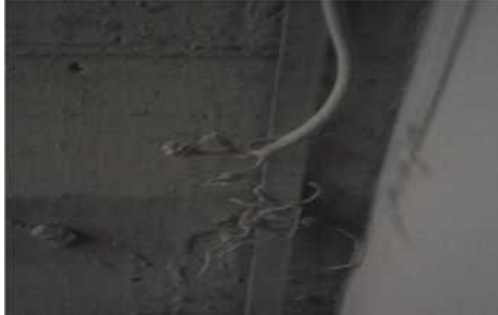
Figure II.8 : Câble dénudé.
