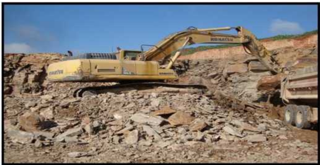
Chapitre V.4 : Pelle à chenille se déplaçant sur un terrain instable
