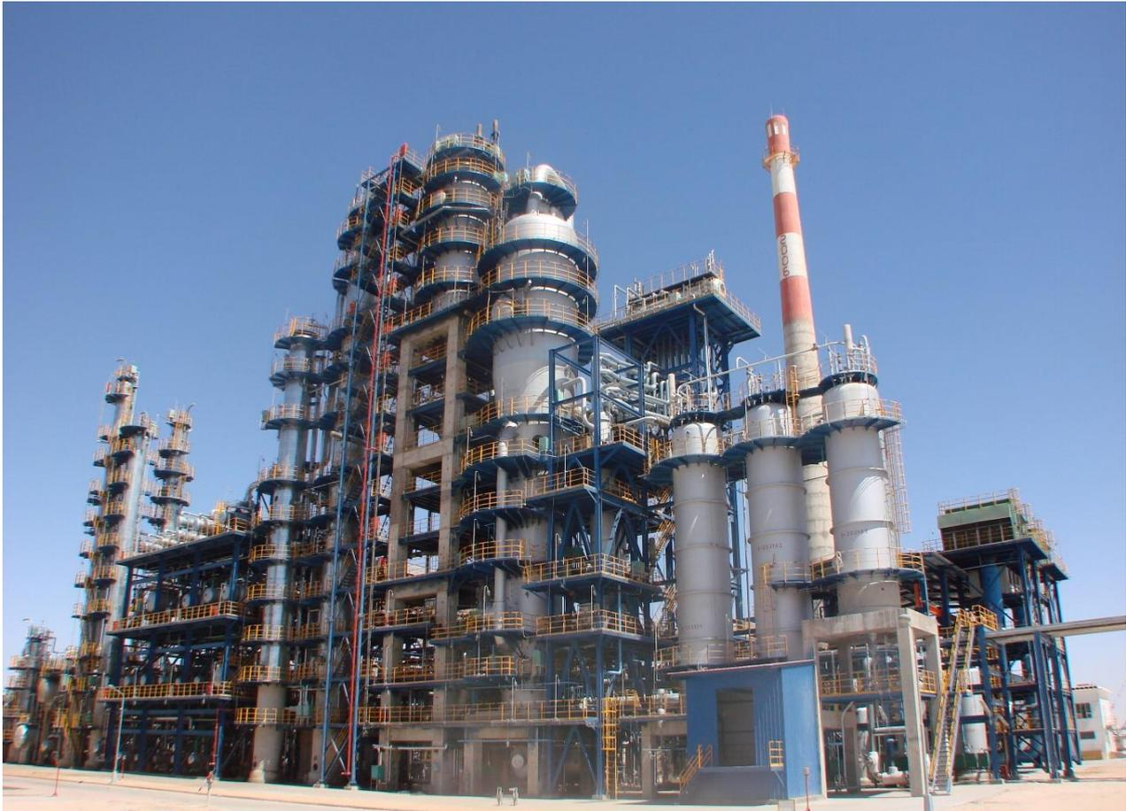
**Figure III.1.** Vue partielle des sections Réaction/Régénérateur et Fractionnement.
