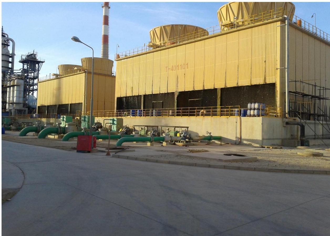
**Figure I.4.** Section de refroidissement de l'eau.
