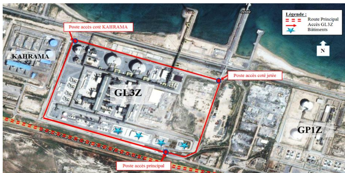
Figure III.4 : Prise aérienne du complexe GL3/Z
