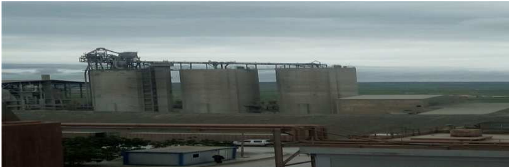
Figure II.12 : zone de stockage dans les silos
