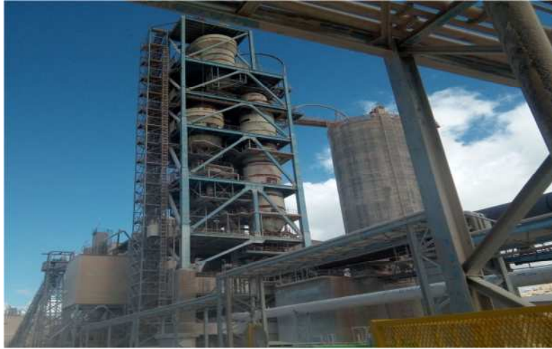
Figure II.8 : échangeur a cyclone
