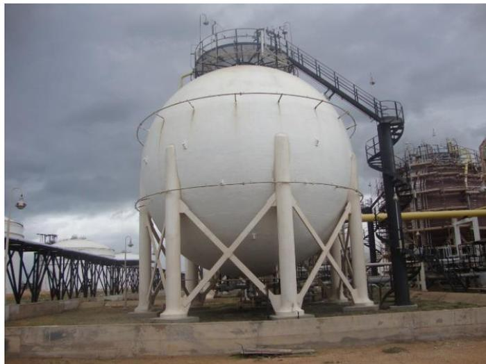
**Figure II.1:** sphère de charge.
