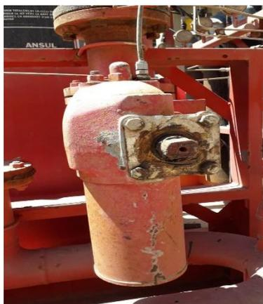
Figure II.5 Vanne pneumatique
