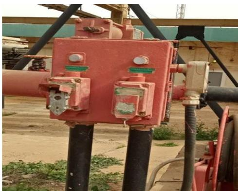
**Figure II.12** Une boîte d'inhibition HTD/LTD
