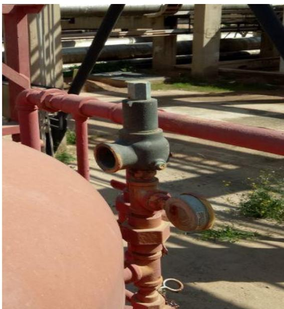
**Figure II.4** *Soupape de sécurité réservoir*
