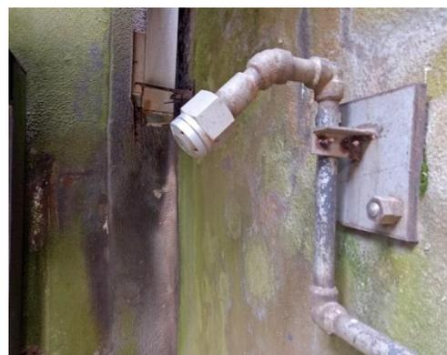
**Figure II.13** Tuyauterie fixe de refoulement avec un ensemble de diffuseurs
