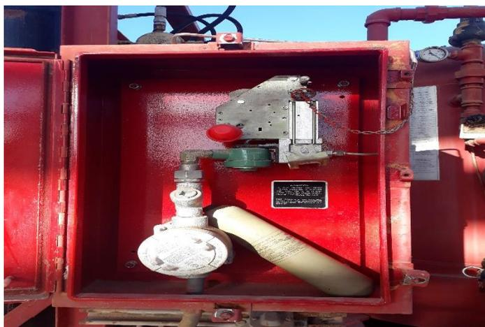
**Figure II.11** Unité d'activation électromécanique AUTOMAN II
