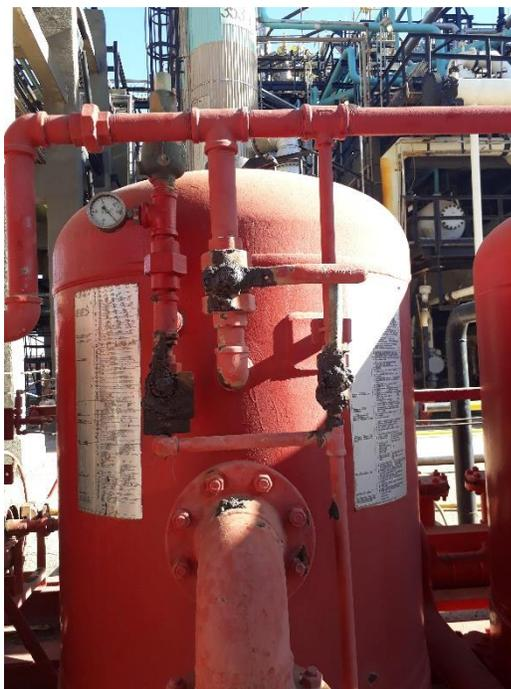
*Figure II.2 Réservoir à poudre chimique*
