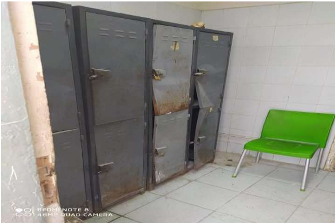
Figure 20: Armoires de vestiaires rouillés
