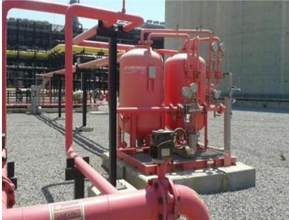
*Figure IV.18: Système mousse (70-ML-03)*
