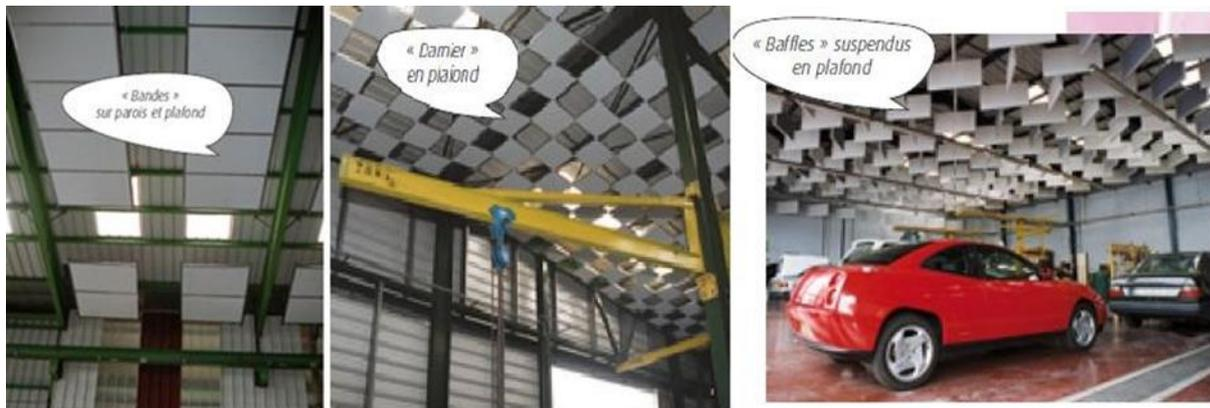
Figure III.8: *Bandes d'absorption de plafond (à gauche), damier (au milieu), baffles (à droite).*
