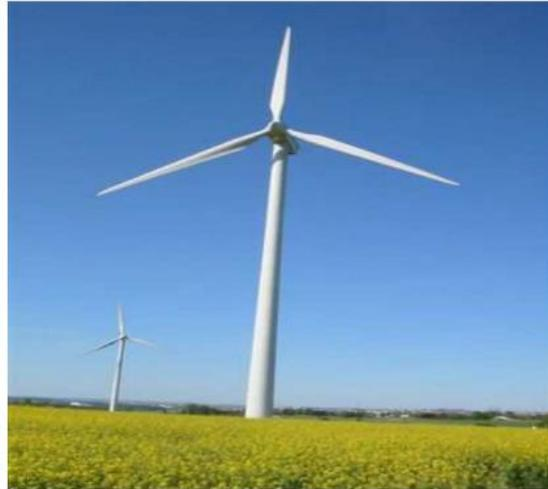
**Figure III.23 :** Aérogénérateur à axe horizontal. [69]
