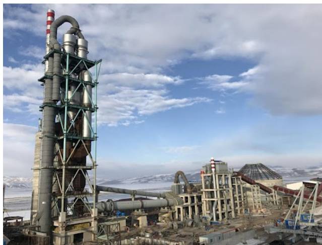
FIGURE I.12 – Préchauffeur multi cyclones.
