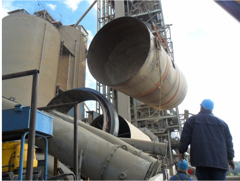
FIGURE I.30 – Montage d'une virole d'un four rotatif.
