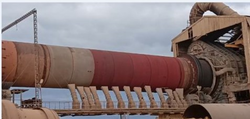
figure ( 29) : four rotatif de l'usine BENI SAF .
