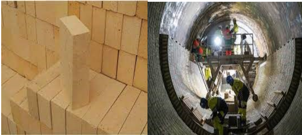
figure ( 14): Briquetage dans un four rotatif de cimenterie.
