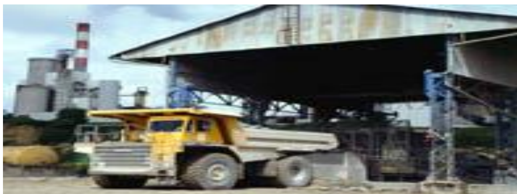
Figure III: 2 Concassage des matières premières au niveau de la carrière.
