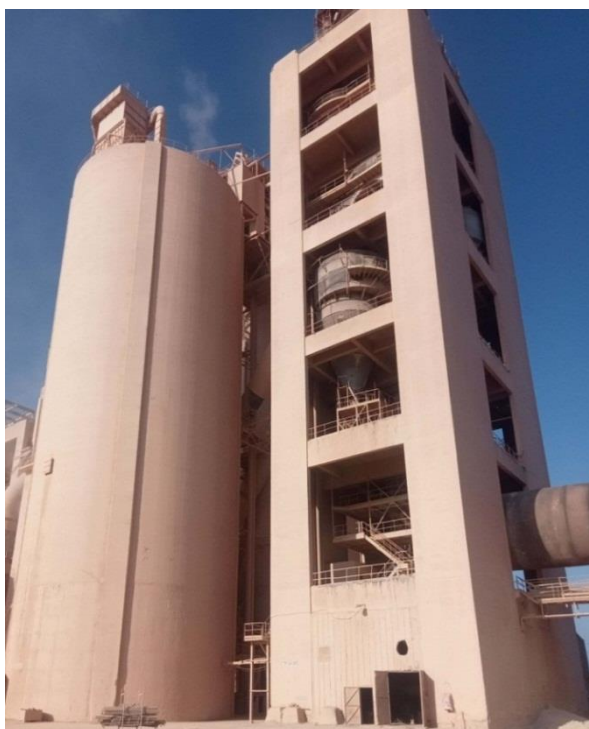
Figure III: 5 Préchauffeurs
