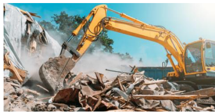
Figure 38.matériaux de démolition
