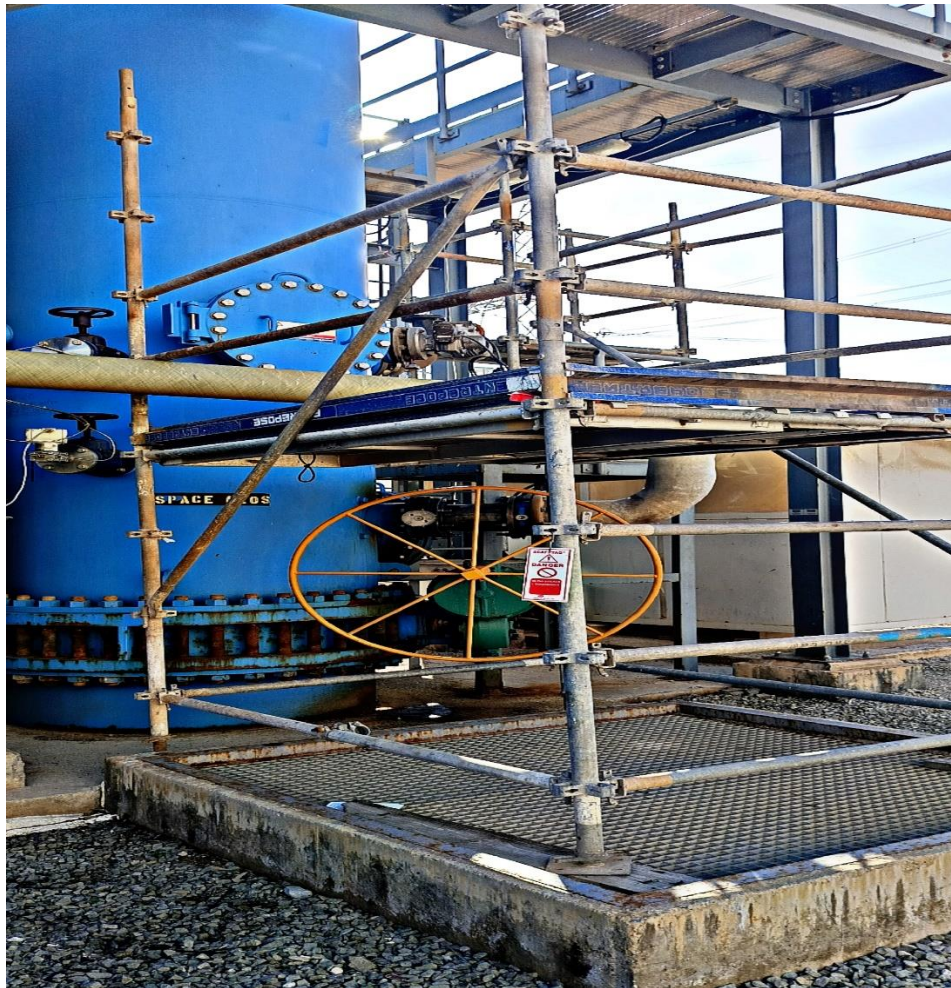
Figure IV.2 : échafaudage fixe utilisé en SNC LAVALIN.
