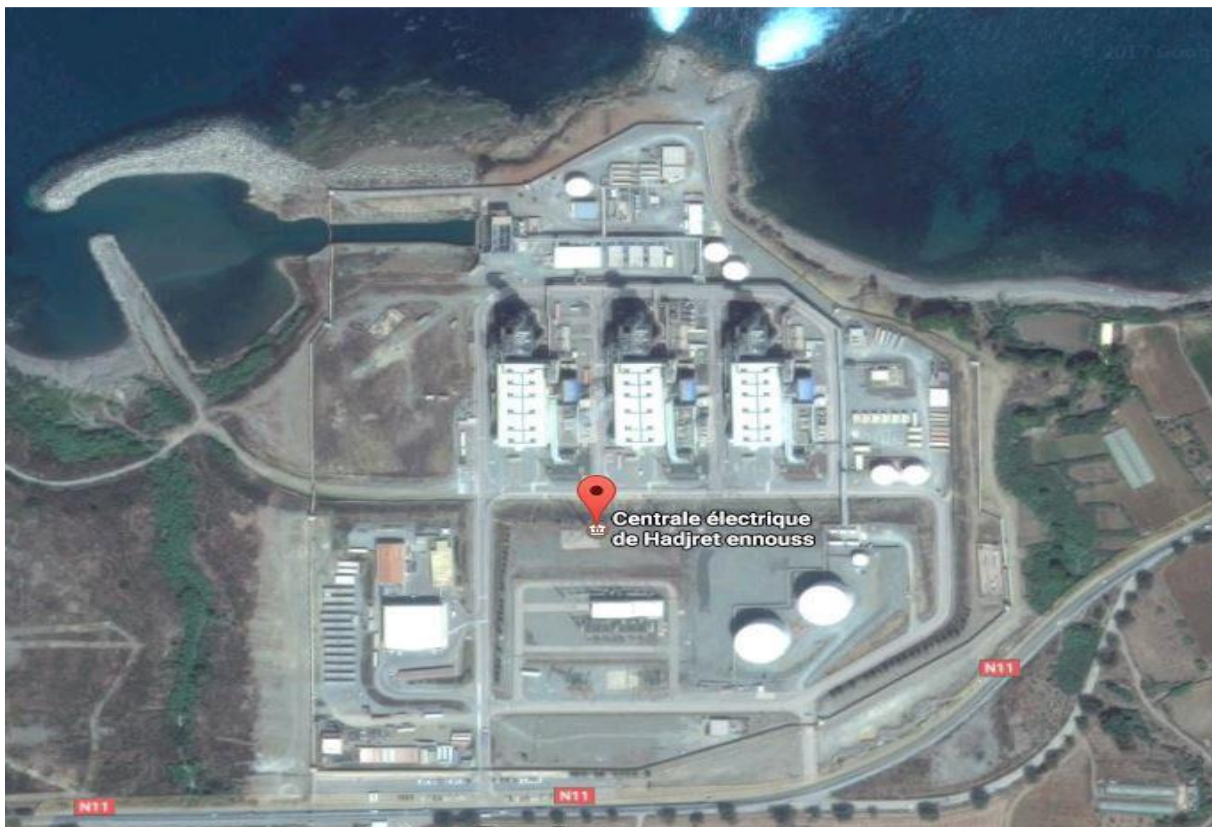
Figure III.2 : Emplacement de l'entreprise [4]
