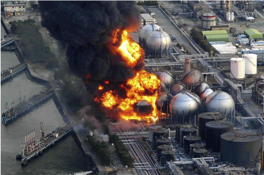
*Figure 8 : BLEVE de sphères GPL dans une raffinerie suite à un séisme du Japon.*
