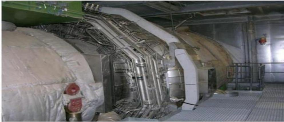
**Figure 2.14.** Système de distribution de combustible
