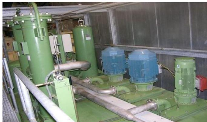
**Figure 2.26.** Pompe à l'huile de graissage.
