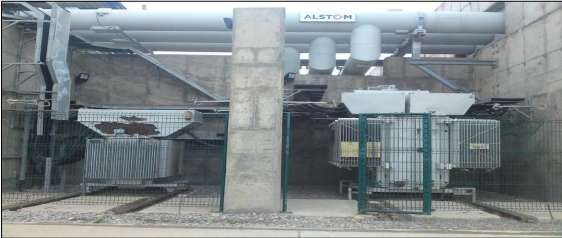
**Figure 2.6.** Transformateurs Auxiliaire et de Démarrage
