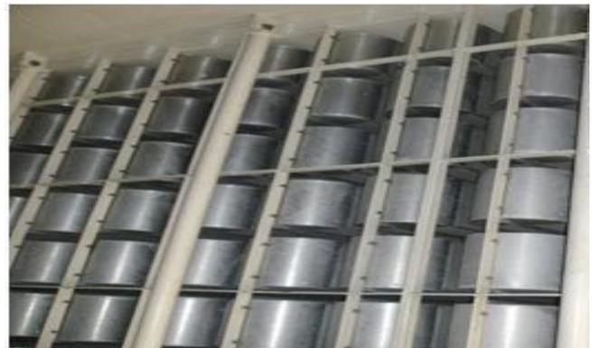
**Figure 2.24.** Filtres d'air.
