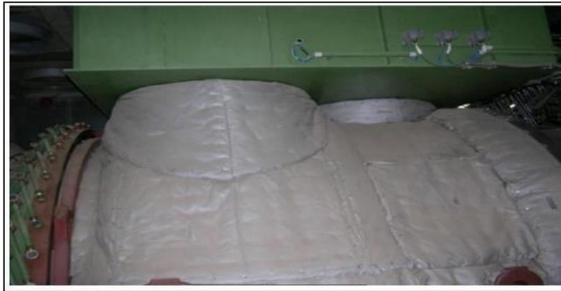
**Figure 2.12.** Le compresseur (vue d'extérieur) avec la vanne anti-pompement Au-dessus (en vert).
