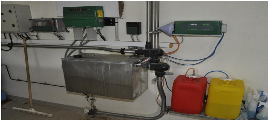
Figure11 : Apré Nettoyage de la machine
