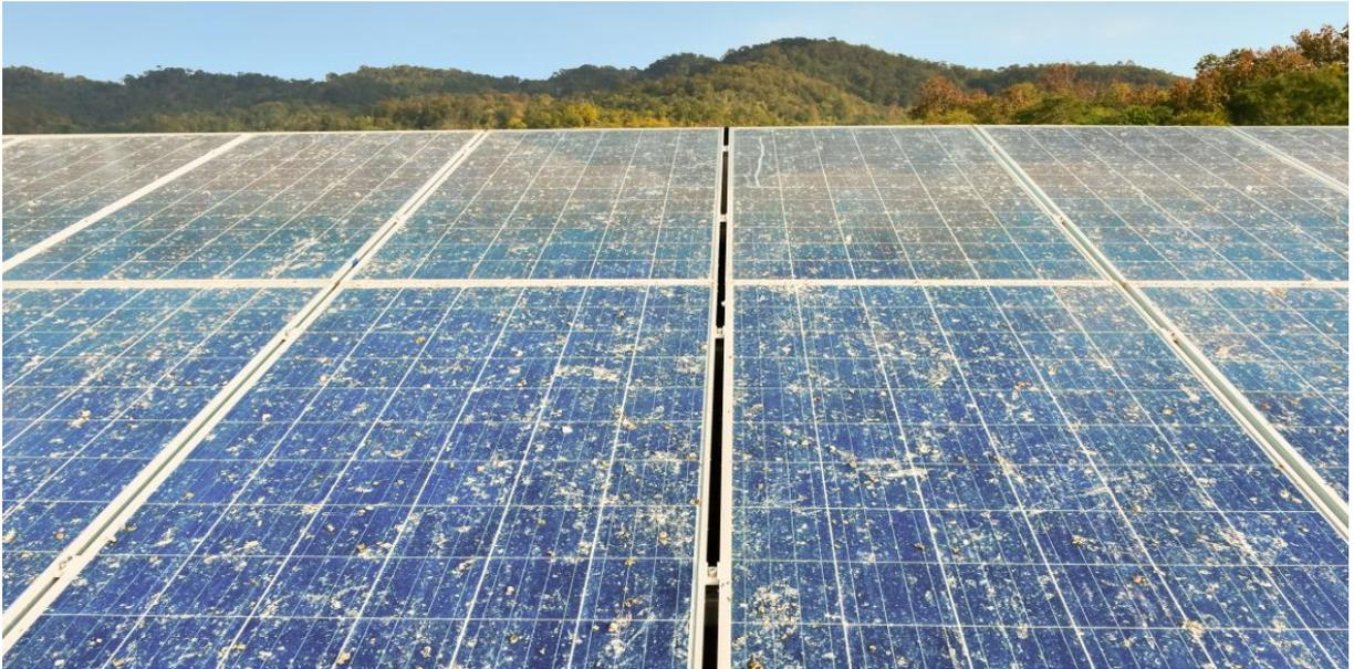
*Figure III.5 : panneaux solaires encrassée*
