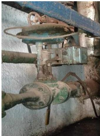
**Figure 8: Vanne pneumatique**
