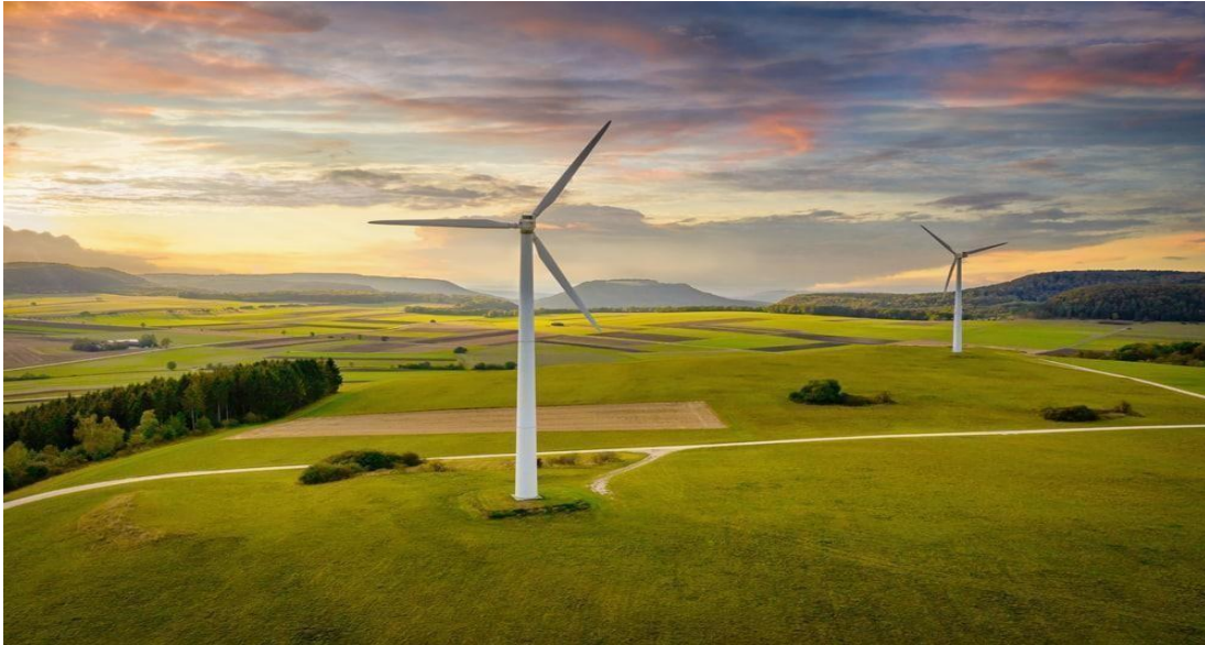
Figure II.5. Éolienne à axe horizontal.
