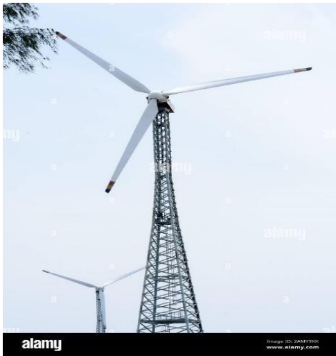
Figure II.7. Tour en treillis.
