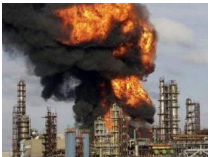
Figure III.3 Explosion du four 100-F1, 3 Janvier 2013
