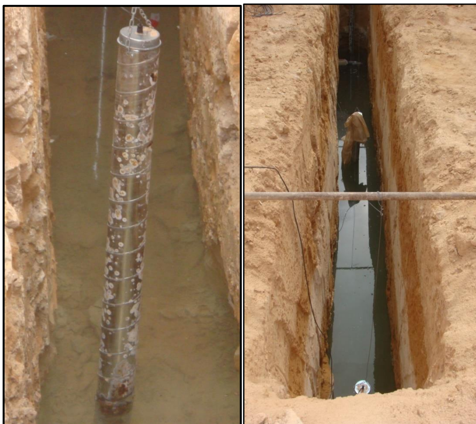
Figure III.2 : Anode posée verticalement dans l'eau de mer.
