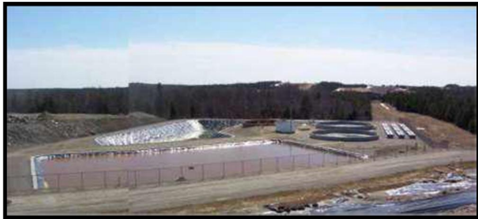
Fig. 3 : Station de traitement de lixiviat.
