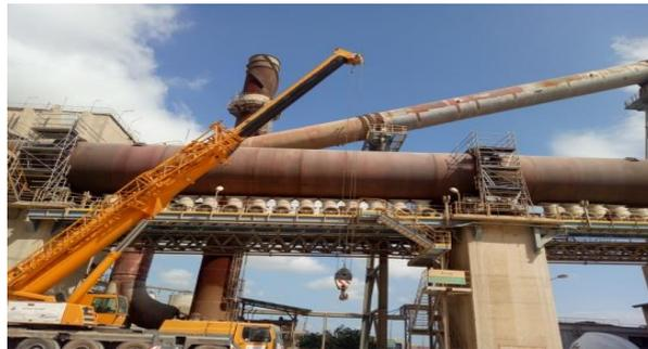
**Fig.I.16 : Four rotatif de LCO.**
