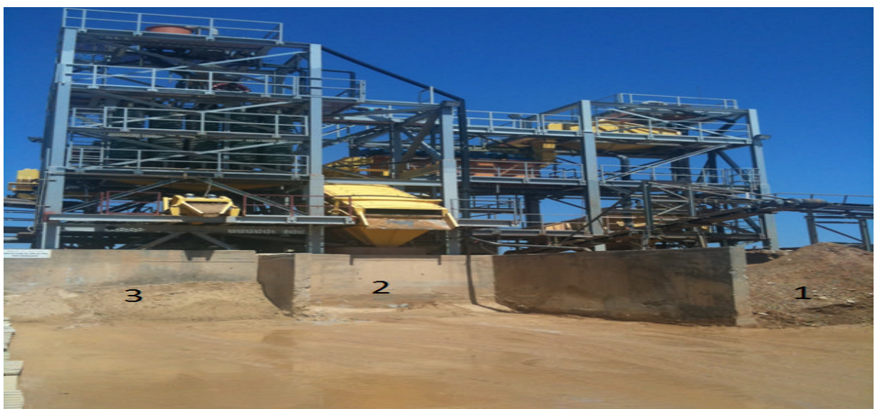
Figure II.7 : Unité de broyage
