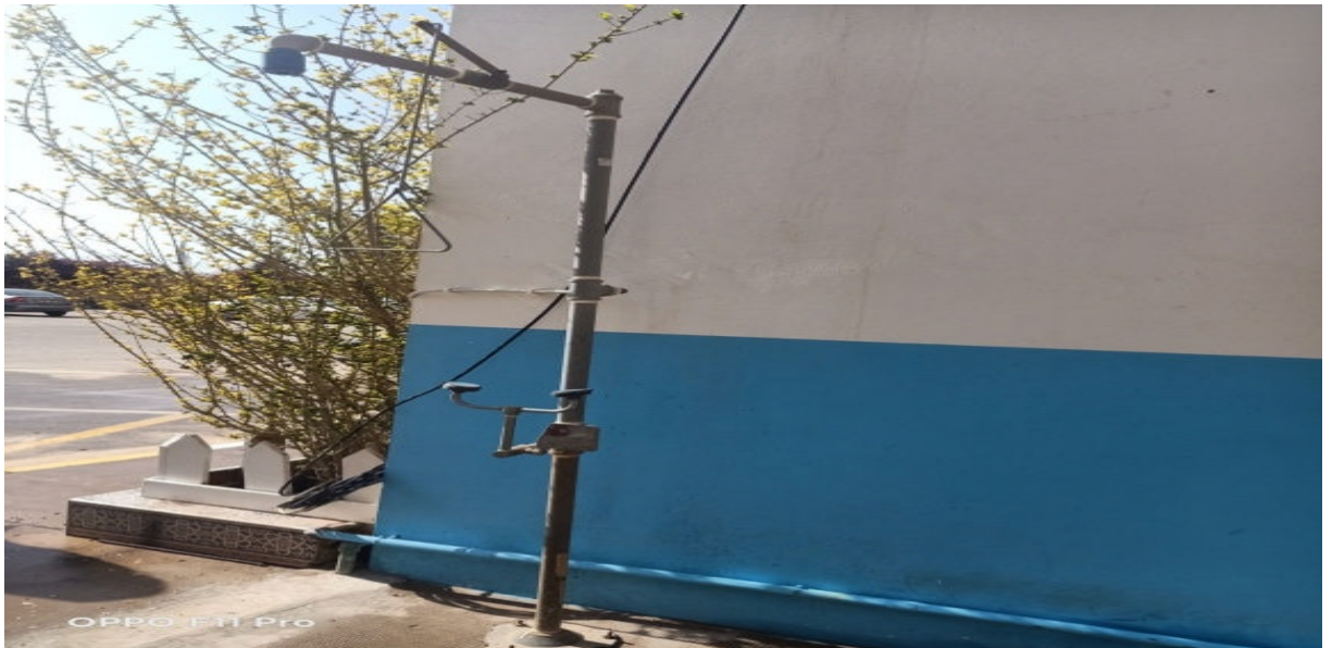
Figure I.26 : Exemple de douche de securite au sein de la société « ADWAN »
