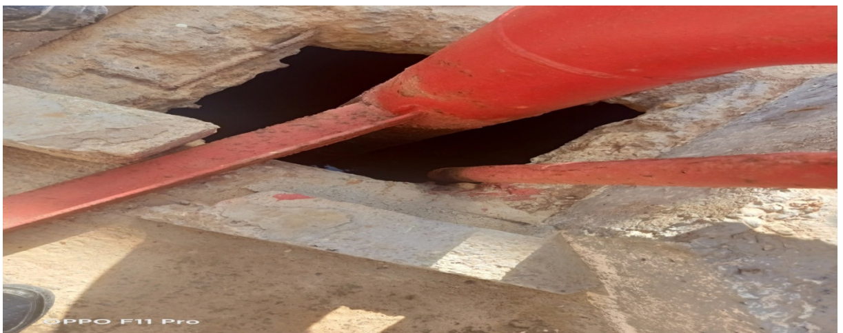
Figure I.18 : Bâche d'eau du site « ADWAN »
