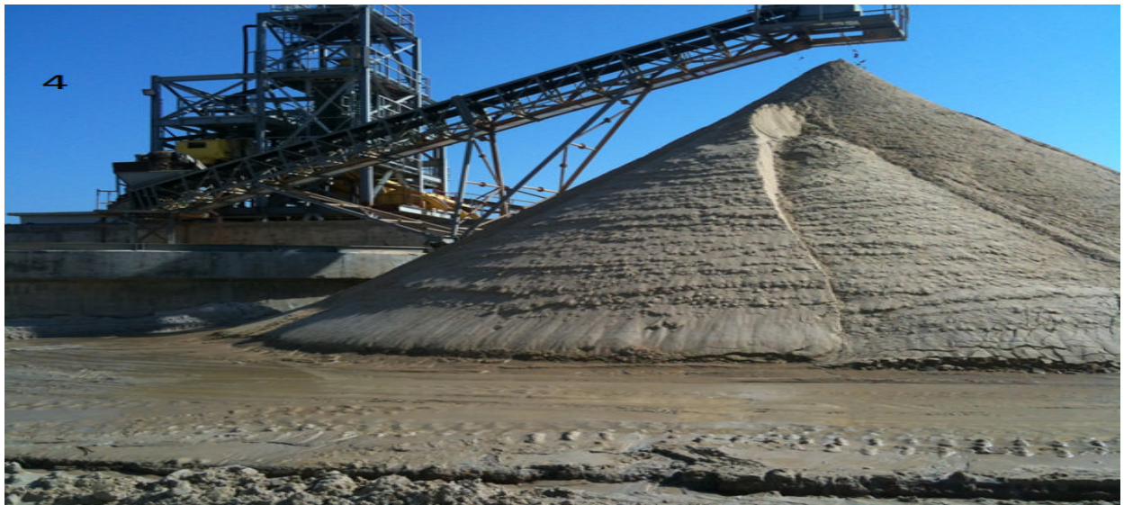
Figure II.6 : Unité de lavage du sable
