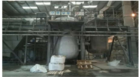
Figure IV.7 Unité de silicate de sodium
