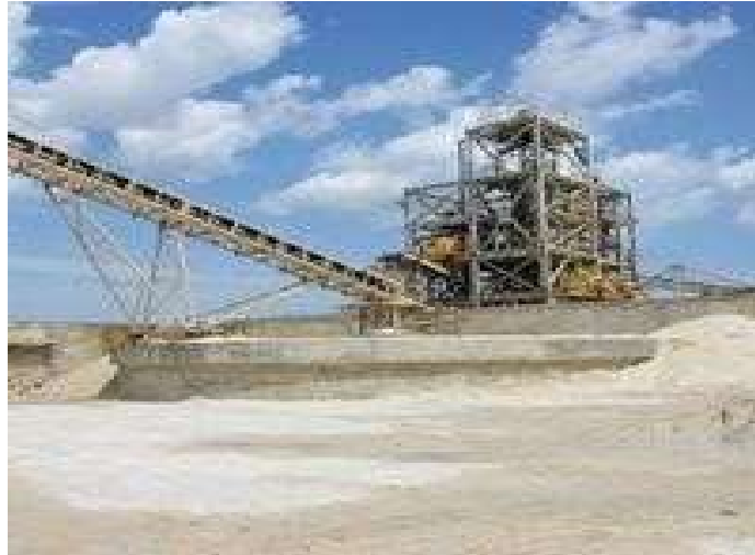
Figure IV.4. Usine de sable
