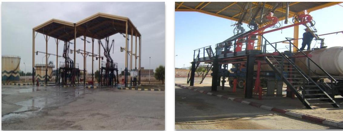
**Figure 4.6 :** *Le poste de chargement et déchargement (camion-citerne)*
