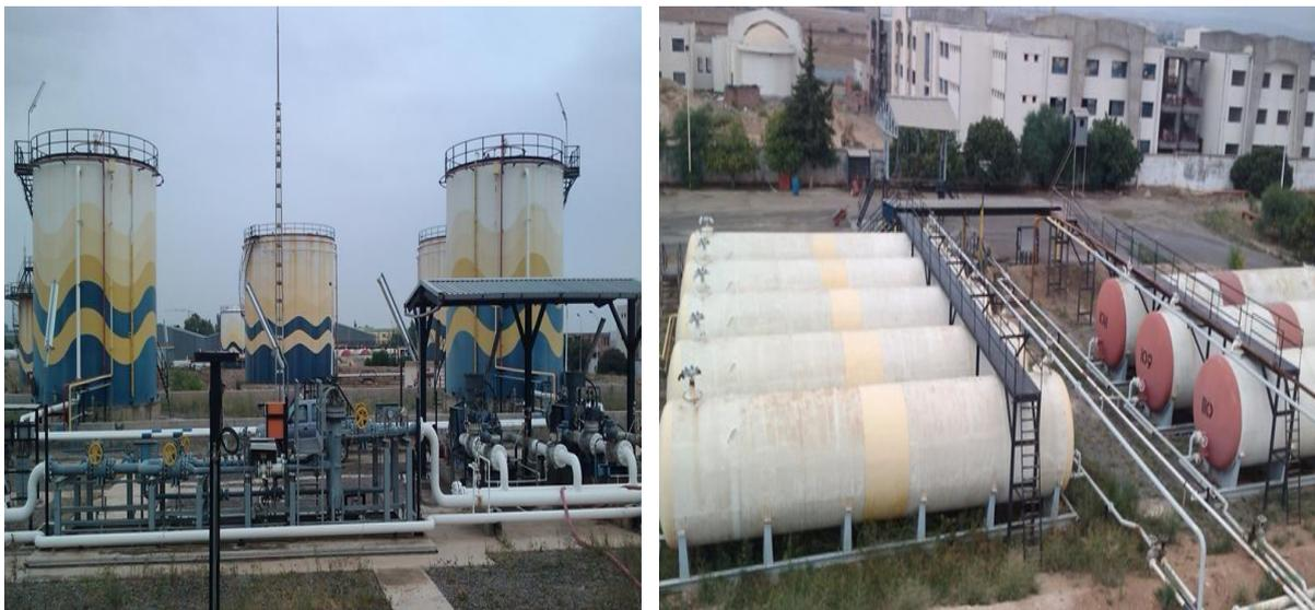
**Figure 4.5** : Le parc de stockage des produits en bacs et cuves
