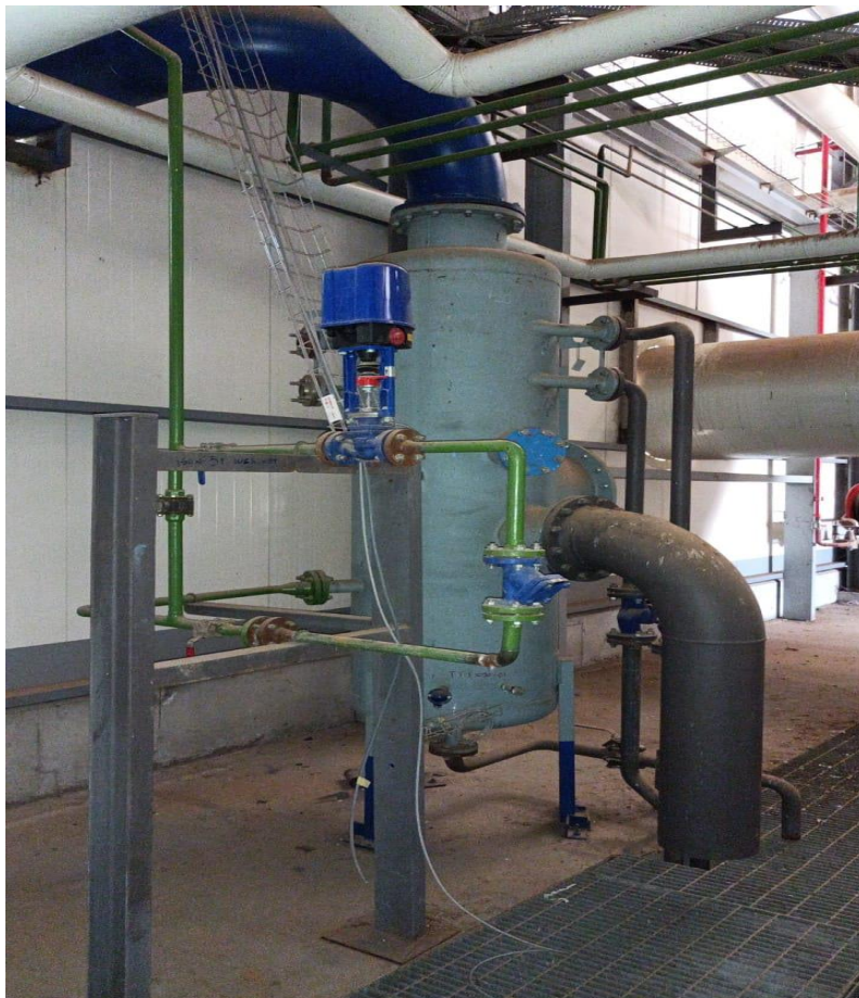
Figure II-3 : pot d'éclatement des purges PRP-800 (Babcock Wanson)
