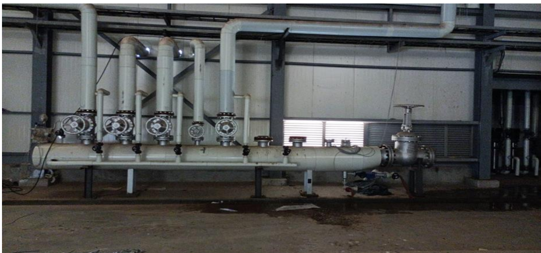
Figure II-4 : Barillet de vapeur DN500 16 bar
