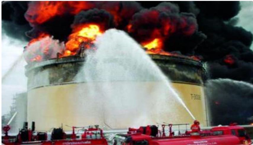
Figure VI.4 refroidissement de bac de stockage
