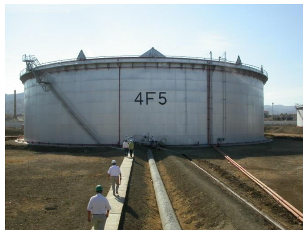
Figure VI.2 Réservoir à toit flottant
