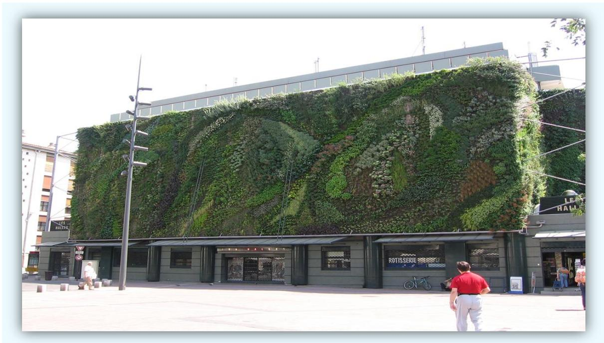
**Figure IV-7:** Mur végétal installé sur la façade des Halles d'Avignon –Place Pie France
