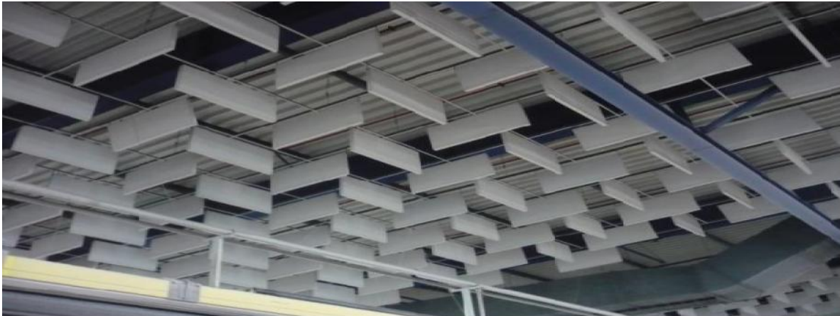
Figure 30 - Plafond de local industriel avec baffles.
