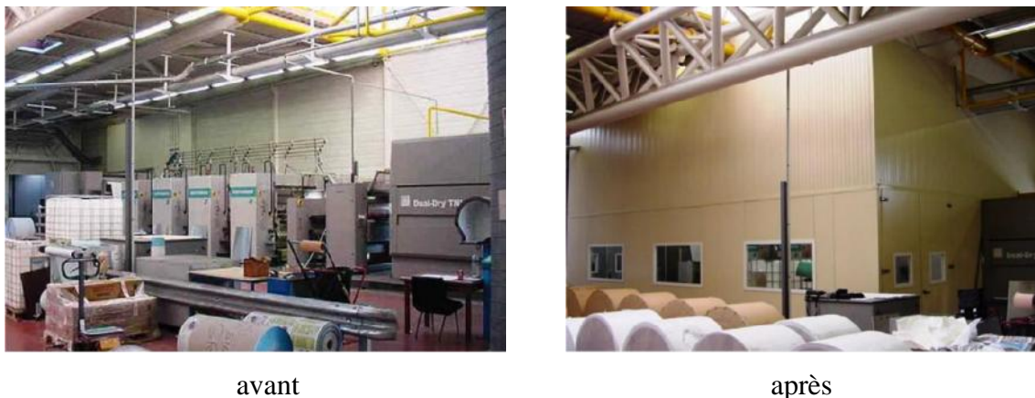
Figure 26 - Local avant et après l'installation d'une paroi hermétique.
