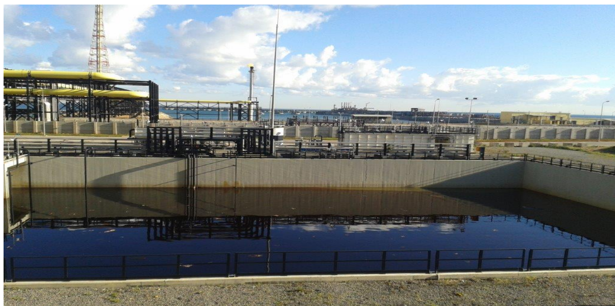
Figure N°19 : Le Bassin de Retenue des Rejets Liquides 64-CV02.
