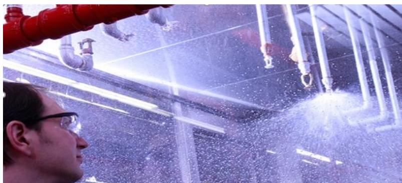
Figure 2-24: Fonctionnement d'une installation d'extinction par sprinkleur [24]
