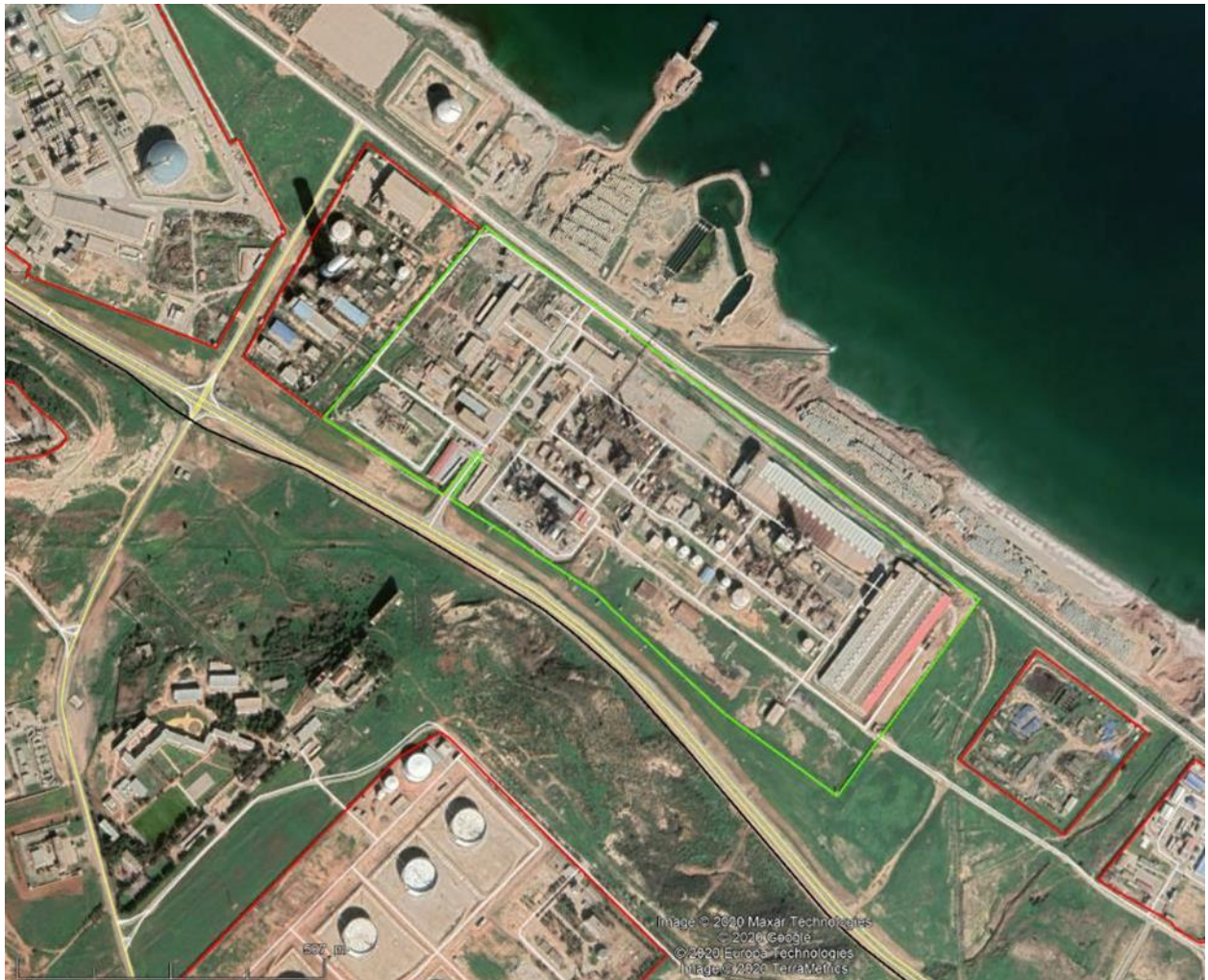
Fig.19 Voies de circulation extérieures à Fertial/Arzew
