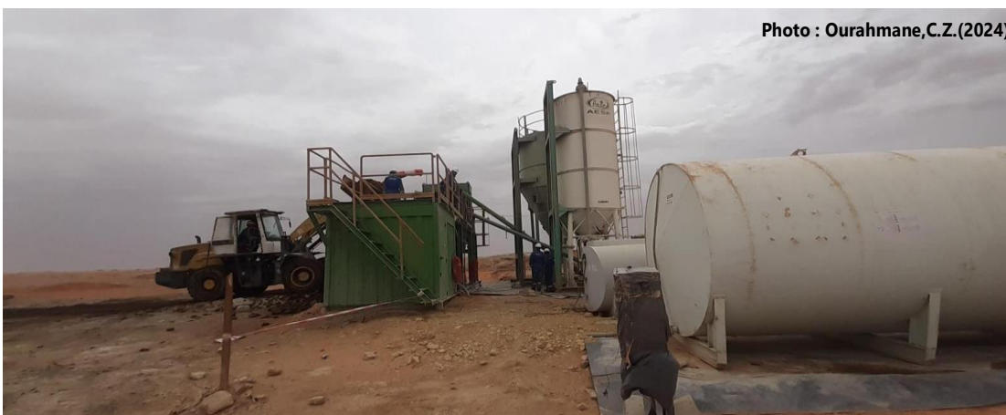
Figure 24 : Traitement par solidification/stabilisation du borbier du puits "TFN2" (cliché O.C.Z mai 2024).
