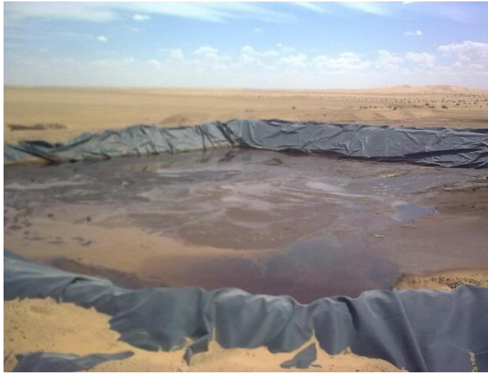
Figure 20 : Exemple de Wet pit (Sonatrach).
