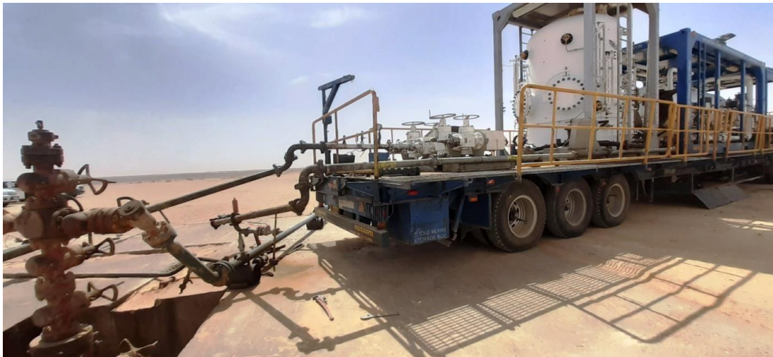
Figure 4 : Opération de gaz-lift de forage à Amassak (Cliché Ourahmane C.Z., 2024).
