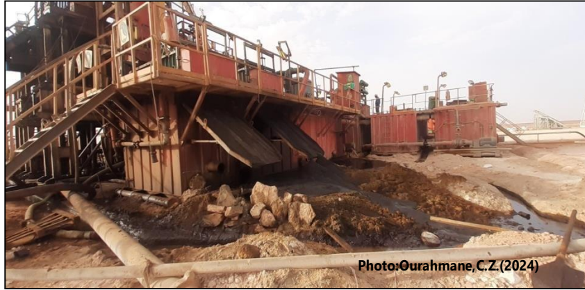
Figure 17 : Boue de forage s'écoulant vers le bac de décantation : puits TFNW 7.
