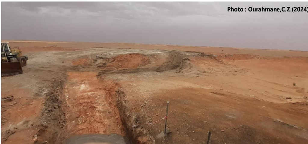
Figure 25 : Fosse d'évacuation de rejets stabilisés : puits "TFN2" (cliché OCZ, 2024).
