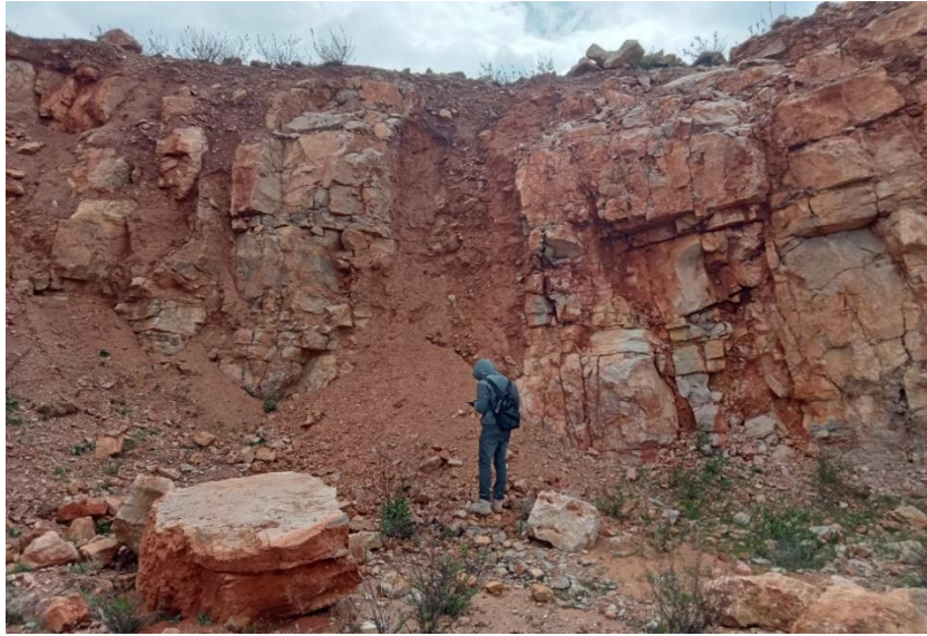
Photo 6.1 : karst remplie de terre végétale.
