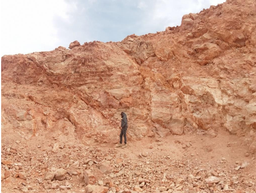
Photo 20.1 : faille secondaire C au niveau 650m de la carrière.
