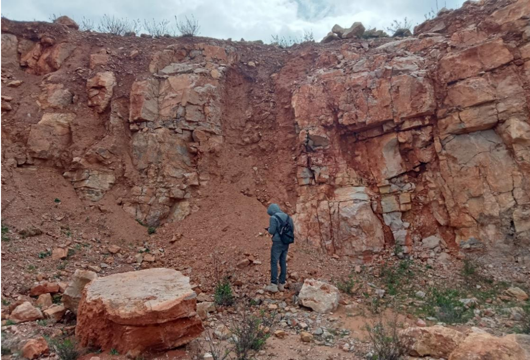
Photo 14.1 : cavité karstique au niveau 650 de la carrière de Sidi Abdelli
