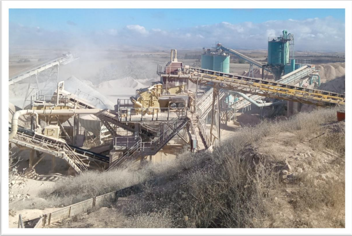
Photo 11 : Station de concassage de la carrière de Sidi Abdelli
