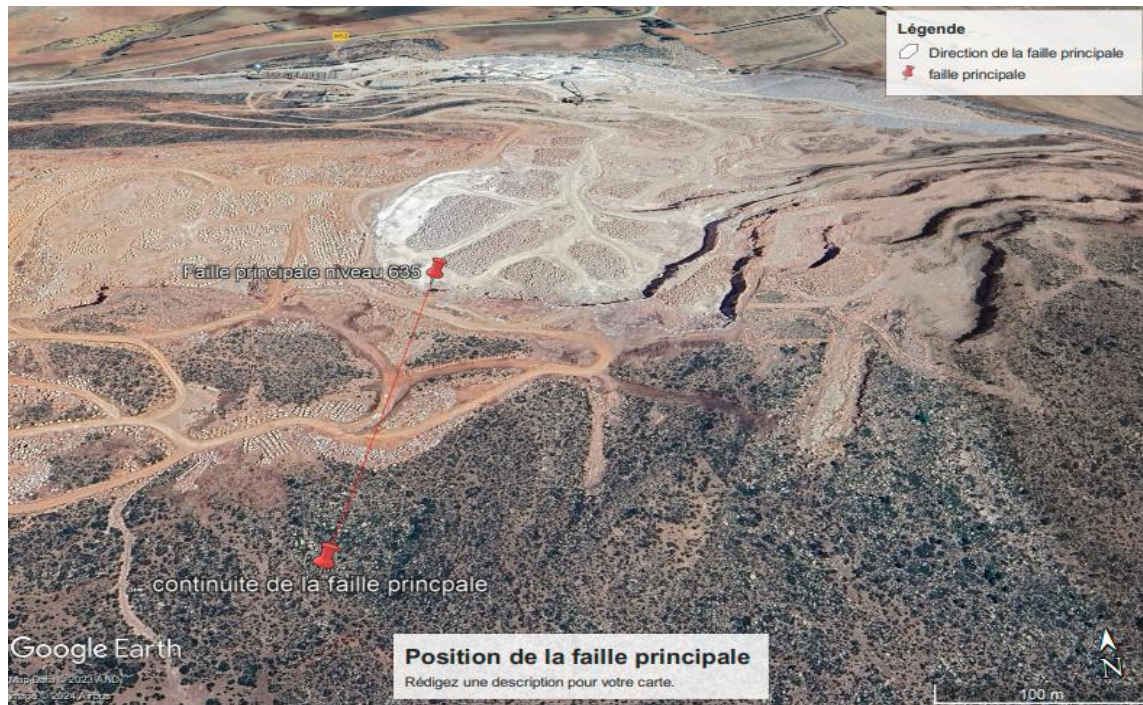
Photo 17.1 : position de la faille principale dans la carrière
