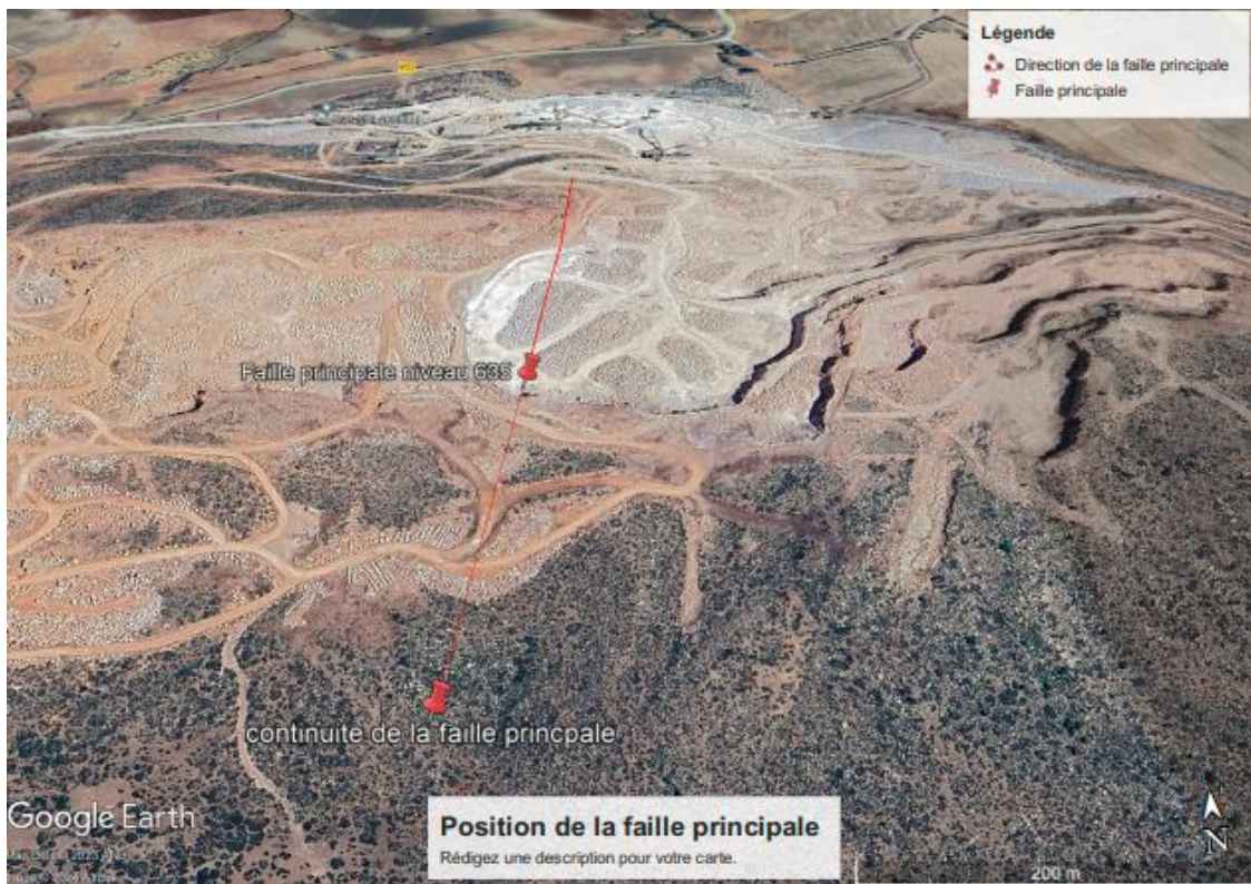
Photo 17.3 : projection de la faille principale qui met en évidence les 2 colline d'exploitation de la carrière
